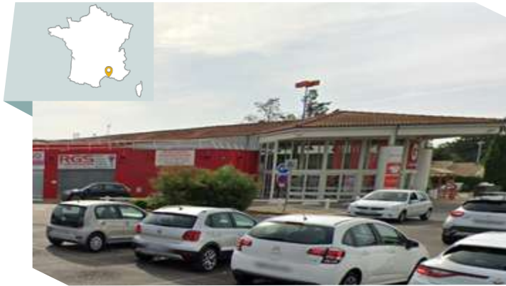
Galerie Saint-Victoret | SAINT VICTORET
